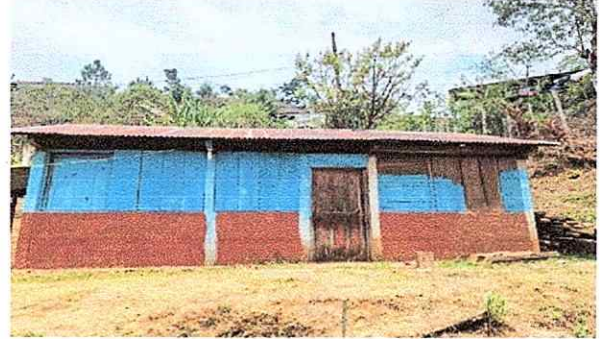
Foto 2: reparacion de techo
