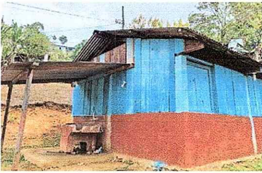
Foto1: reparacion de cocina
