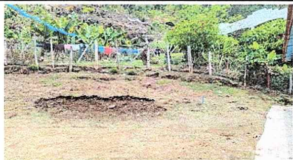
Foto 6: reparacion de piso
