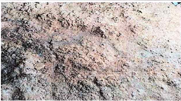
Foto 3: reparacion de piso
