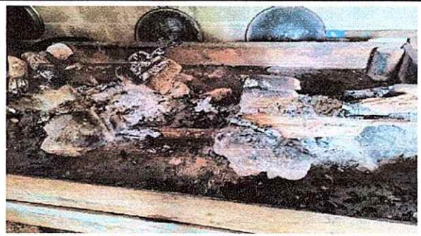
Foto 4: sustitucion de polleton
